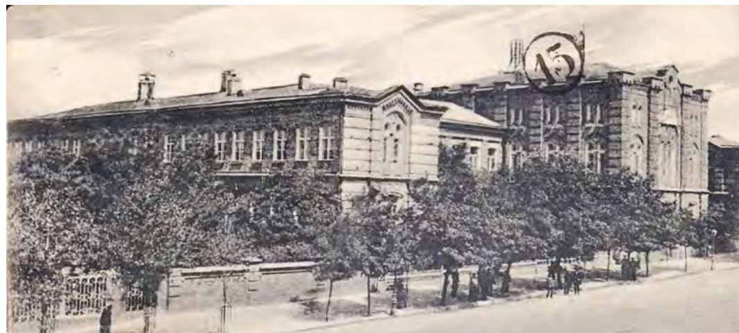
Здание Петровского реального училища на улице Большая Садовая, 1877 г. (фотографии 1890-95 гг.)
